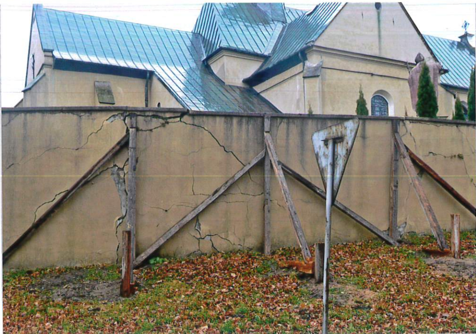
Fot. 6. Mur oporowy, widok od północnego-wschodu.
