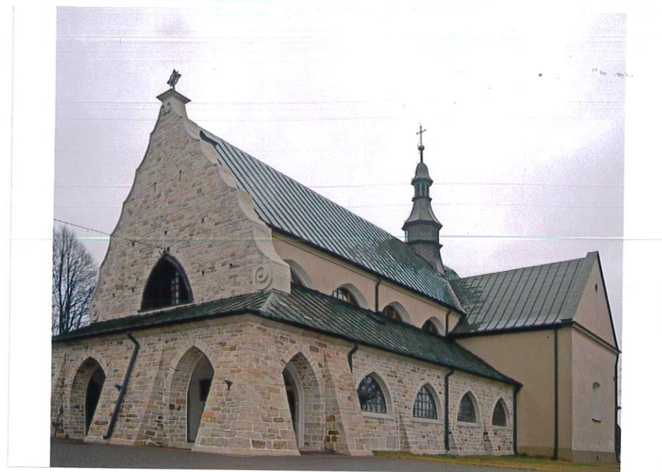
Fot. 7. Portyk kościoła, widok od południowego-zachodu.
