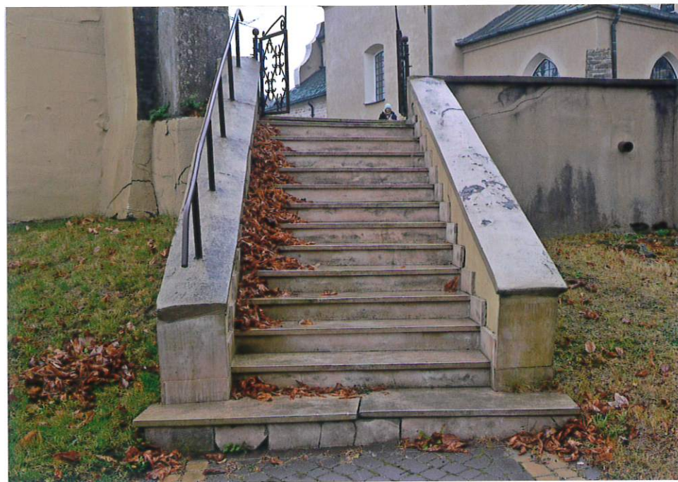
Fot. 9. Schody boczne, widok od południowego-wschodu.
